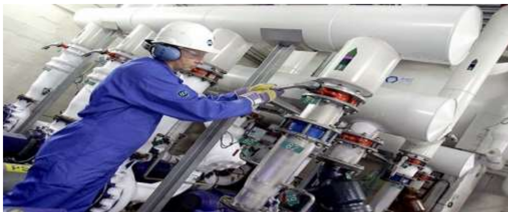
Figura 8 - Manutenção Preventiva na Prática.
