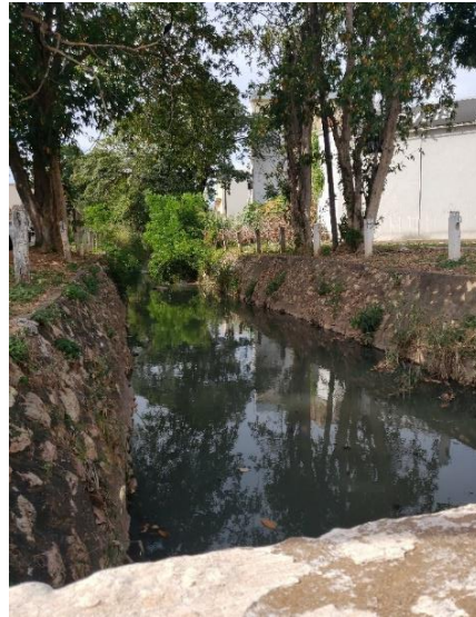
Figura 40: Início da canalização aberta
