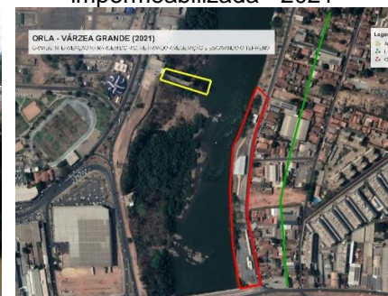
Figura 32: Orla já finalizada e impermeabilizada - 2021
