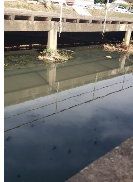
Figura 41: Canalização aberta – Bairro Araés
