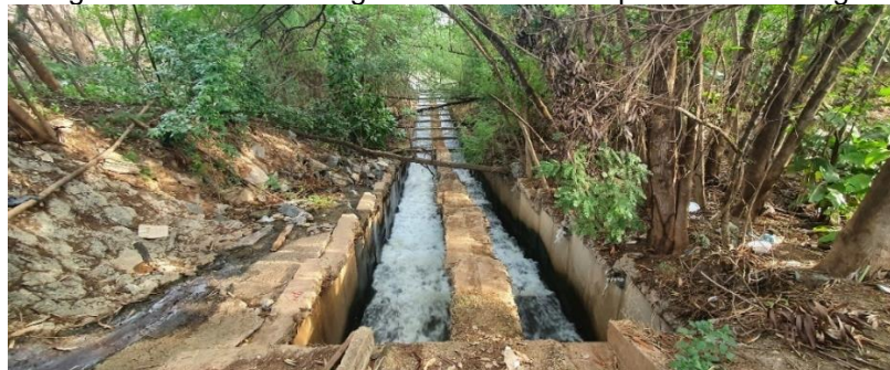
Figura 47: Foz do córrego Gambá com dissipadores de energia
