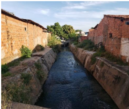
Figura 45: Ocupações irregulares no córrego Gambá - Av. General Mello
