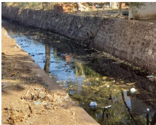
Figura 58: Córrego Água Limpa - Próximo ao Shopping
