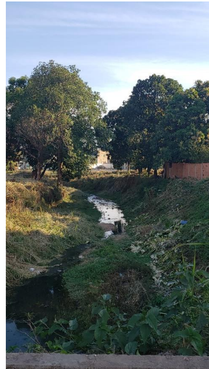
Figura 48: Parte do leito do Córrego Barbado
