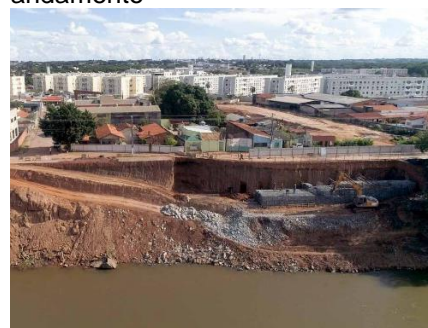
Figura 31: Obras da Orla em andamento
