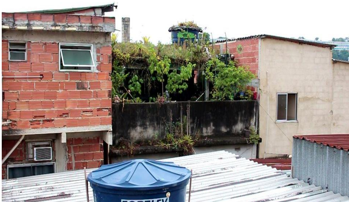
Figura 12 – Telhado Verde na Favela – Rio de Janeiro/RJ
