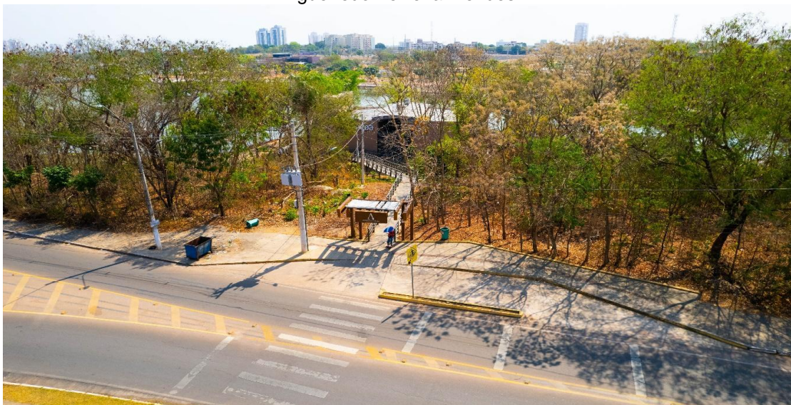
Figura 58: Representação do Entorno Parque das Águas – Vista: Avenida Desembargador Milton Figueiredo Ferreira Mendes.
