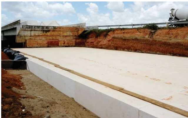
Figura 39 – Nivelamento de estrada com EPS
