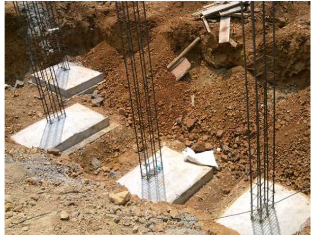
Figura 16 – Fundação do tipo sapatas isoladas
