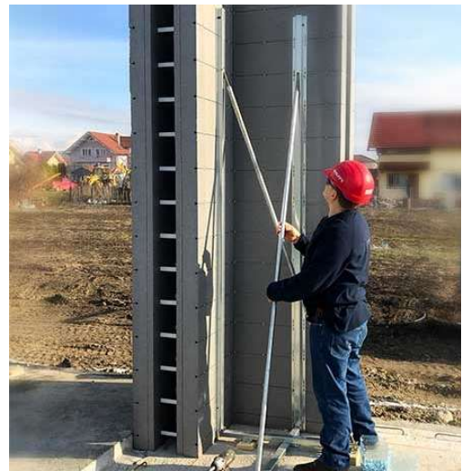
Figura 24 – Montagem dos cantos no sistema Thermodul
