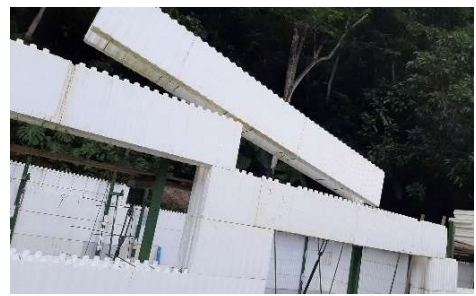
Figura 46 – Montagem com o sistema ICF
