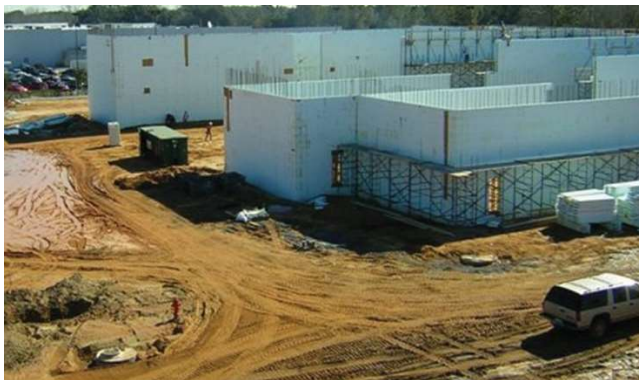
Figura 57 – Aspecto do canteiro de obras
