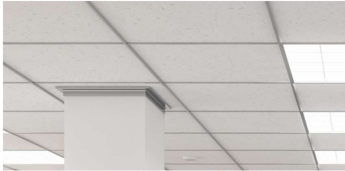
Figura 35 – Forro de EPS montado
