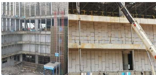
Figura 19 – Obra com o sistema construtivo em Painel Sanduiche Cimentício
