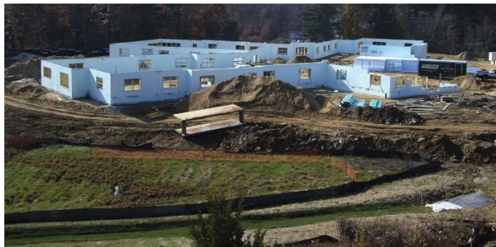
Figura 69 – Aspecto do canteiro de obras
