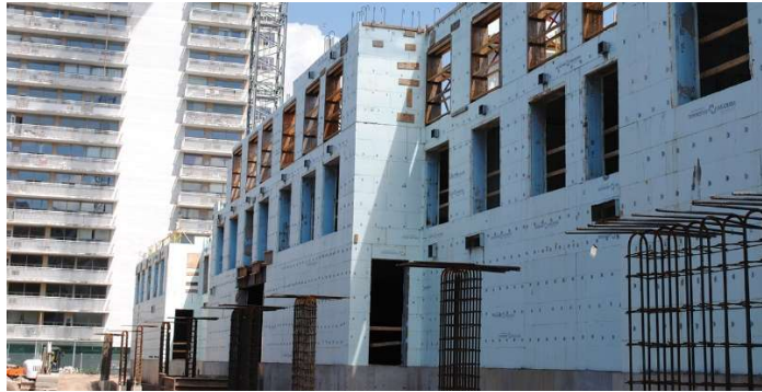
Figura 67 – Aspecto do canteiro de obras
