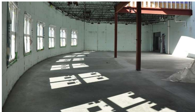
Figura 65 – Aspecto do canteiro de obras
