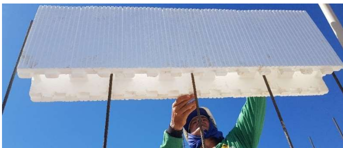
Figura 45 – Posicionamento das formas de ICF
