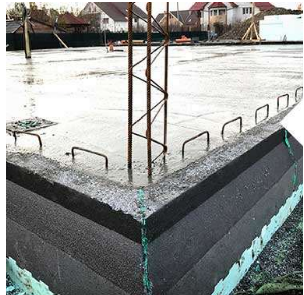
Figura 26 – Ganchos de espera do sistema Thermodul
