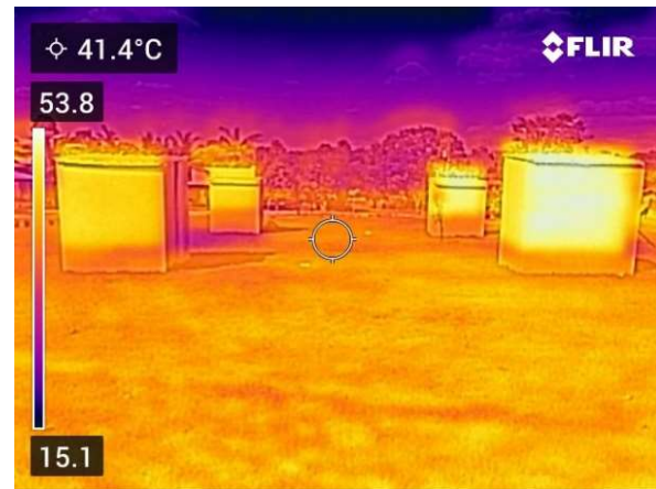
Figura 113 – Imagem térmica gerada pela Câmera termográfica compacta
