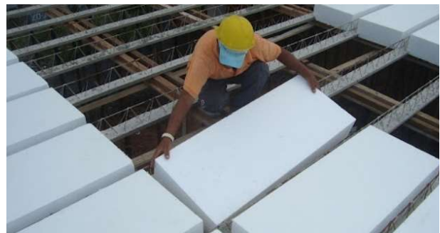
Figura 28 – Uso de lajota de EPS na construção civil
