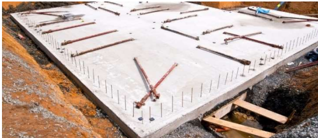
Figura 43 – Fundação do tipo radier
