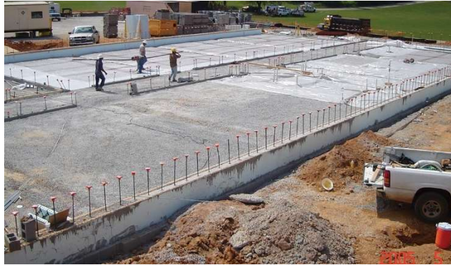
Figura 59 – Aspecto do canteiro de obras
