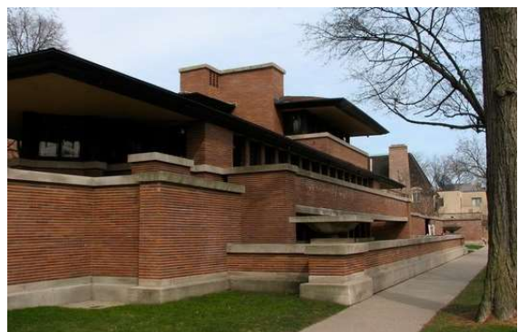
Figura 74 – Casa Robie House em Chicago – Frank Lloyd Wright
