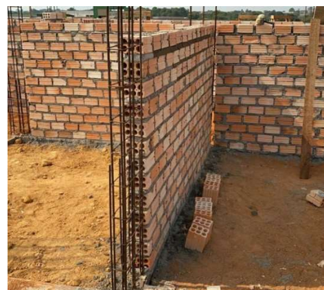
Figura 105 – Assentamento do tijolo cerâmico (uma vez) em uma obra residencial
