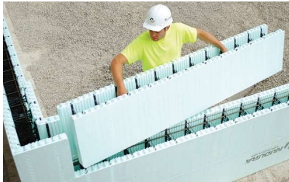
Figura 41 – Montagem das formas do sistema ICF
