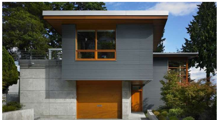
Figura 22 – Edificação executada com o sistema de Painel Sanduiche em Painéis Cimentícios
