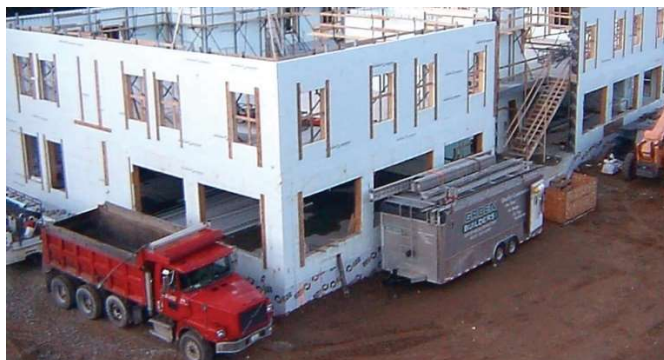
Figura 61 – Aspecto do canteiro de obras
