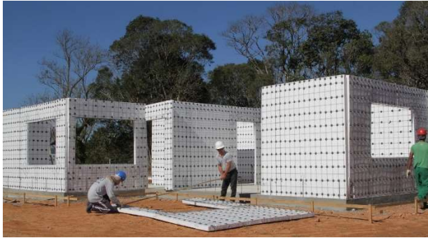
Figura 17 – Fixação dos painéis monolíticos de EPS
