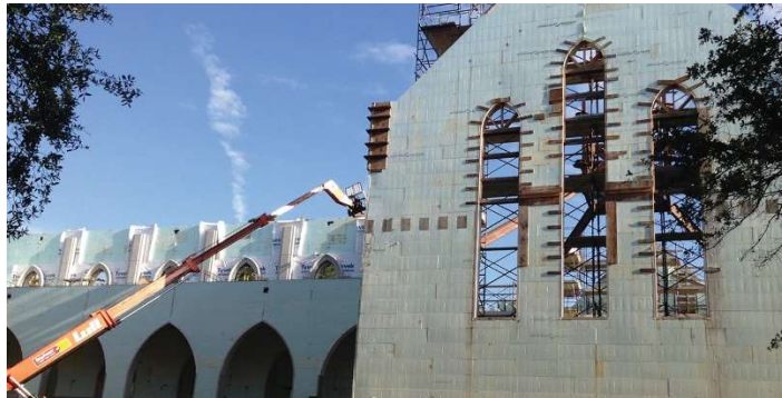
Figura 71 – Aspecto do canteiro de obras
