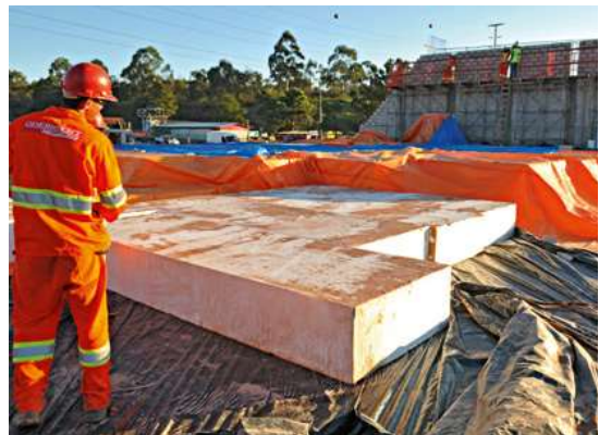
Figura 40 – Execução de aterro em Jundiaí-SP
