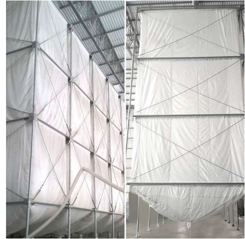
Figura 12 – Silo de armazenamento
