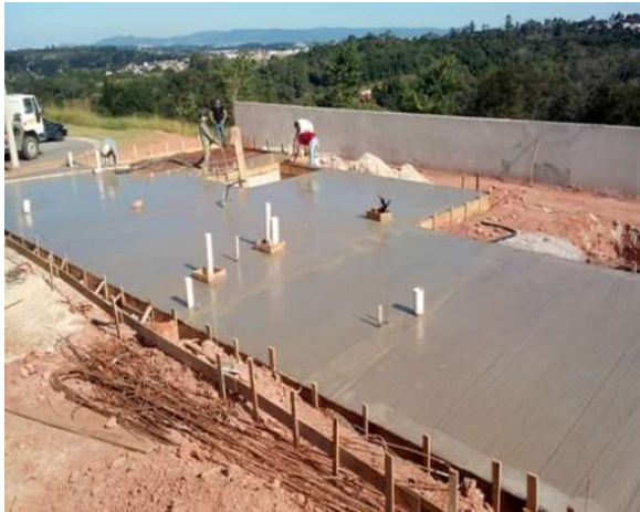
Figura 15 – Fundação do tipo Radier
