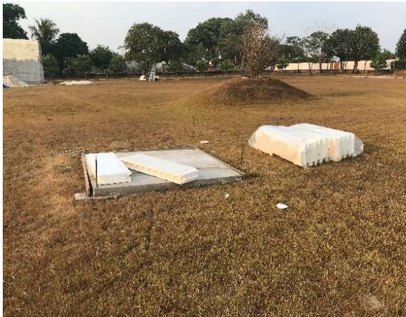
Figura 98 – Radier pronto para receber as formas de ICF Iforms 12
