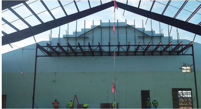
Figura 63 – Aspecto do canteiro de obras
