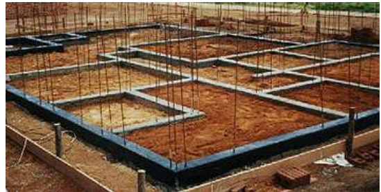
Figura 44 – Fundação do tipo vigas baldrame
