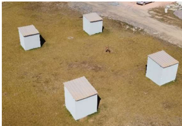
Figura 95 – Imagem aérea dos quatro protótipos construídos
