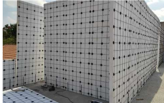
Figura 18 – Fixação dos painéis nas barras
