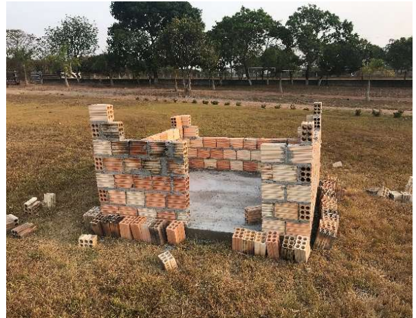
Figura 99 – Execução da alvenaria de tijolo cerâmico em pé (meia vez)
