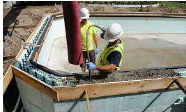
Figura 42 – Concretagem do sistema ICF
