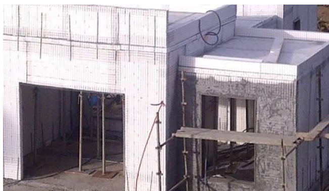
Figura 13 – Painéis monolíticos com EPS
