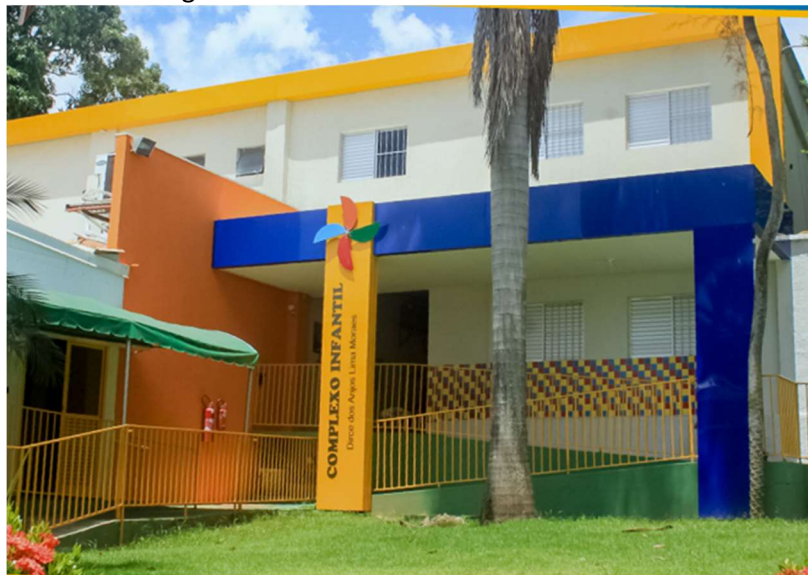
Figura 13: Acesso ao Bloco Infantil da EPC.
