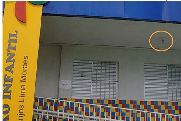
Figura 28: Áreas de Permanências Transitórias iluminadas por luz elétrica.
