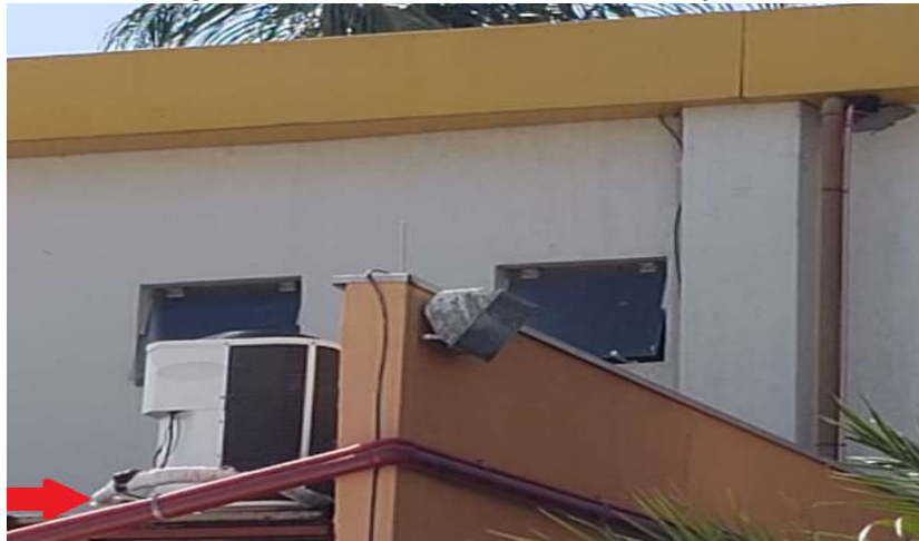
Figura 32: Isolamento térmico de tubulações.
