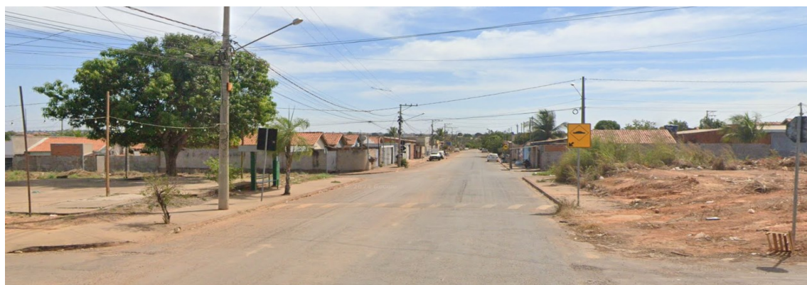
Figura 39 - Ponto de ônibus, ao lado esquerdo com abrigo e no lado direito apenas placa de ônibus na Avenida A do Residencial Nova Canaã
