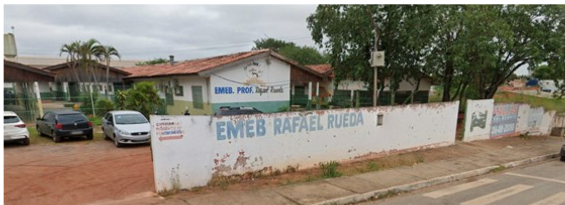
Figura 28 - Escola de Ensino Fundamental Rafael Rueda no entorno do Residencial Nova Canaã
